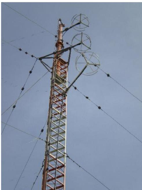
Figura 5 – Antena FM e DRM+ da estação de transmissão da UFMG.
