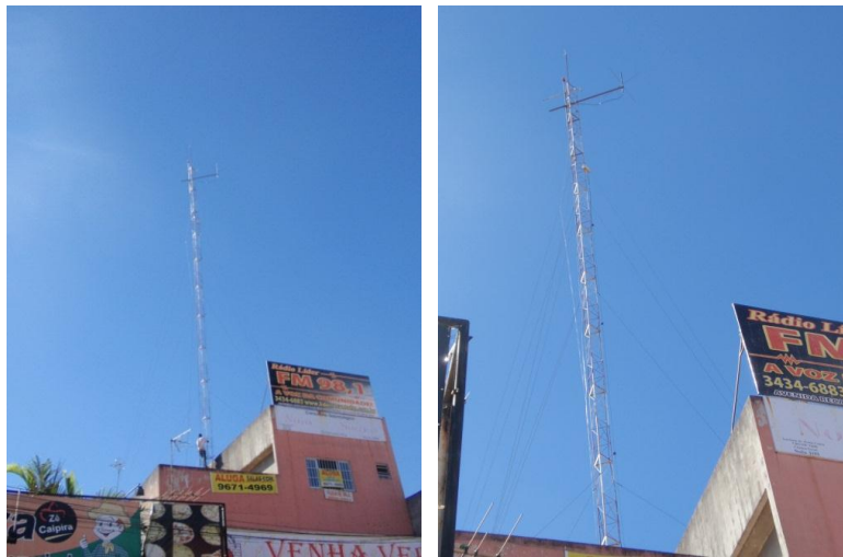
Figura 7 – Visão do mastro (esq.) e detalhe da antena de dois elementos (dir.) da emissora AREMAS utilizada nos testes
